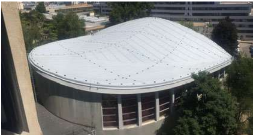
Celkový pohľad na hotovú strechu
