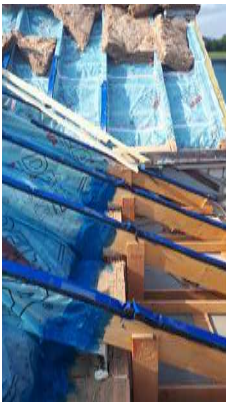
Obrázok 8, 9: Doteplenie krokiev pomocou prírezov fólie DELTA®-MAXX COMFORT a aplikácia poistnej hydroizolácie DELTA®-FOXX PLUS
