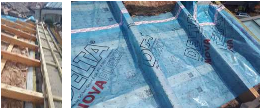
Obrázok 4, 5: Demontáž jednotlivých vrstiev a aplikácia parobrzdý DELTA®-NOVAFLEXX
