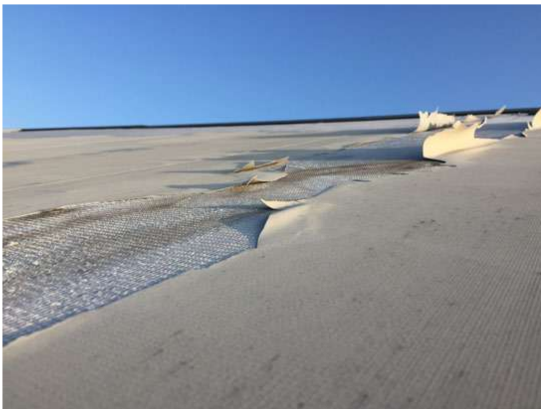
Obr. 4 UV degradovaná mPVC povlaková krytina v štádiu rozpadu (foto: M.Kováč)
