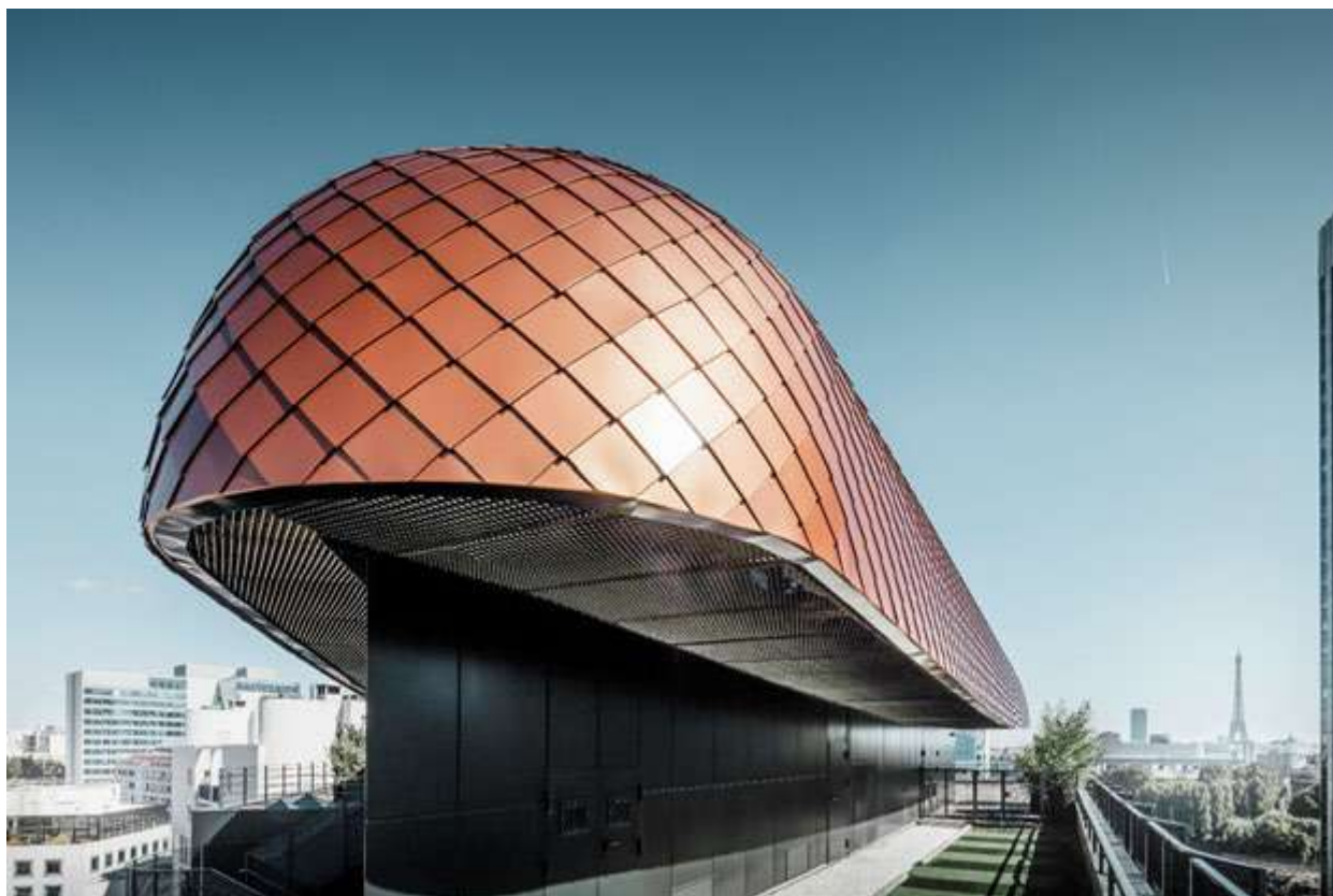
Obr.č.11, 12 ,13 – AB Black Pearl – Paríž, La Défense – Aplikácia systému PREFA šablóna 29x29, farba novomedená
