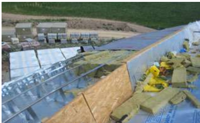
Obr.č.6,7,8,9 – Športová hala – Dolní Břežany – Aplikácia systému PREFA šindel', Al prírodný, prevedenie stucco
