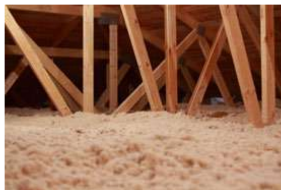
voľné fúkanie do väzníkového krovu
