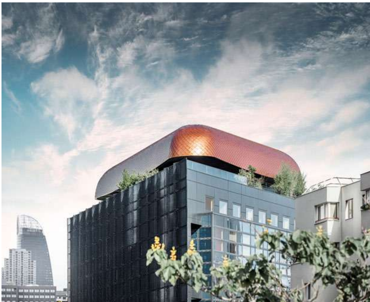
Obr.č.10 – AB Black Pearl – Paríž, La Défense – Aplikácia systému PREFA šablóna 29x29, farba novomedená
