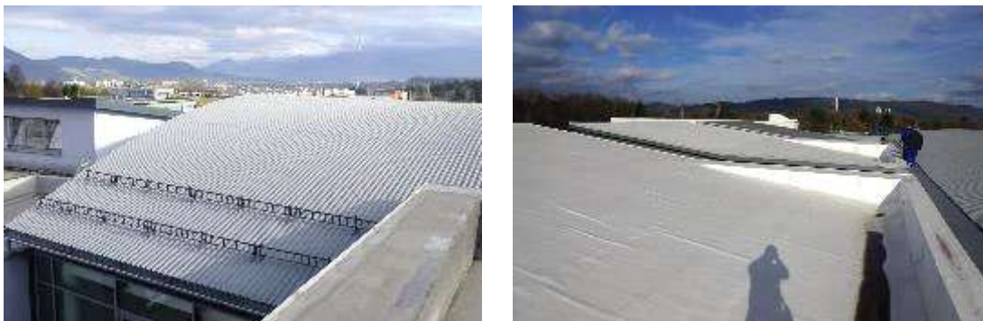
Obr. 4: Pohľad na oblúkové zastrešenie hlavného vstupu a vpravo obnovená povlaková krytina náterom nad dvomi aulami
