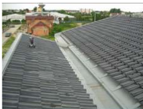
Obr. č. 3-4: pájkovaný spoj: bodový prestup, odvetranie kanalizácie a medzistrešný žľab pájkovaný spoj – žľabová dilatácia, čielka, vpust'
