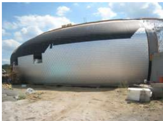
Obr.č.6,7,8,9 – Športová hala – Dolní Břežany – Aplikácia systému PREFA šindel', Al prírodný, prevedenie stucco
