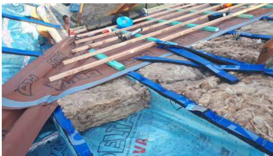
Obrázok 6, 7: Napojenie parobrzdý DELTA®-NOVAFLEXX na obvodové murivo – aj v komplikovaných detailoch prostredníctvom DELTA®-LIQUIXX
