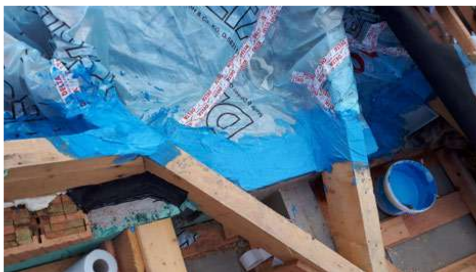
Obrázok 6, 7: Napojenie parobrzdý DELTA®-NOVAFLEXX na obvodové murivo – aj v komplikovaných detailoch prostredníctvom DELTA®-LIQUIXX
