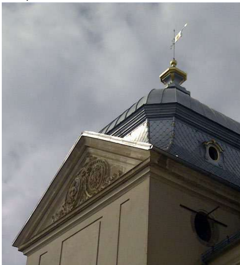
Obr. č. 18: Zámok Halič: RHEINZINK prePatina walzblank, kombinácia dvojité stojatá drážka, pod ozdobným profilom maloformátové šablóny, spotreba 29 ks/m 2
