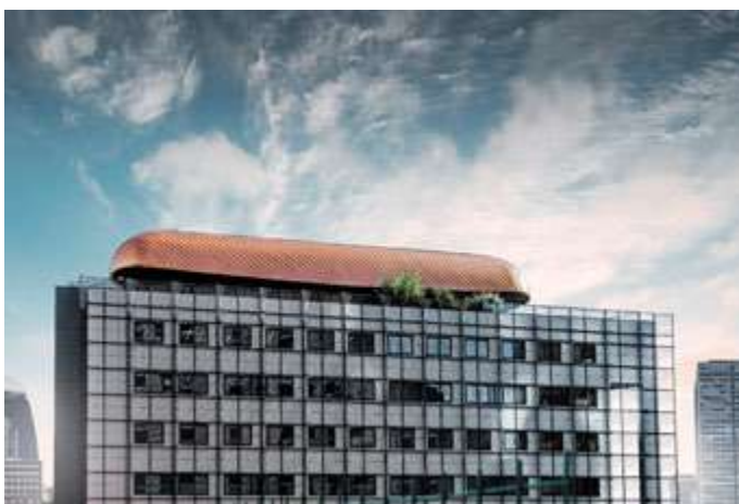
Obr.č.10 – AB Black Pearl – Paríž, La Défense – Aplikácia systému PREFA šablóna 29x29, farba novomedená
