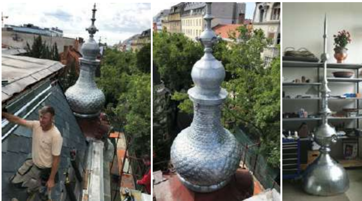
Obr. č. 19: prebiehajúca rekonštrukcia objektu Slovenský poľovnícky zväz Bratislava, Štefánikova ul., RHEINZINK prePatina walzblank a MD materiál. Šikmé časti kosoštvorcové šablóny, vežička MD plech. Úplne vpravo detailný záber na hroticu vežičky v dielni ornamentálneho klampiara.
