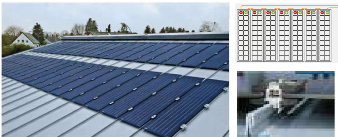
Obr. č. 16: RHEINZINK PV panel, Model 20 výkon cca 100 Wattpeak. Schéma zapojenia a detailný pohľad na kotviaci systémový klip.
