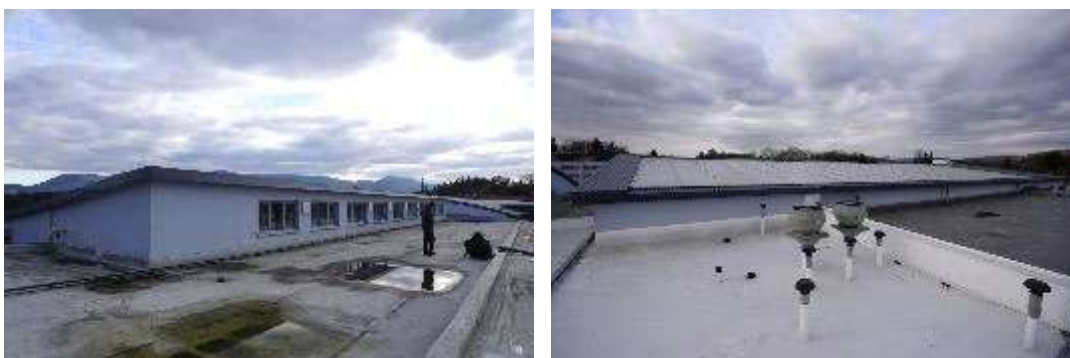
Obr. 2: Pohľad na časť strechy nad blokom AF pred rekonštrukciou. Vyvýšená časť obsahuje svetlík (vpravo)
