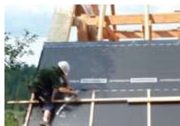
Obr. 2 Potřeba slepování přesahů membrány DHV (zdroj JUTA a.s.)
