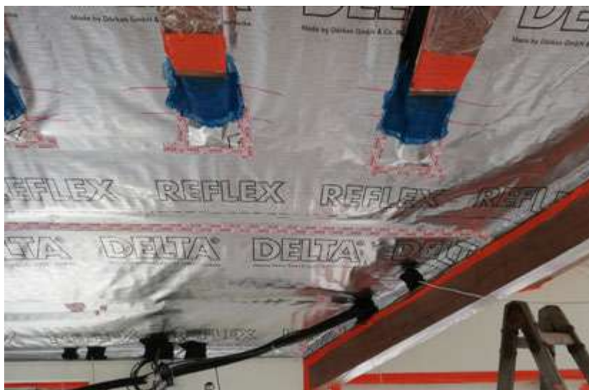
Obrázok 10, 11: Doteplenie doskami PIR a vyriešenie vzduchotesnosti v bazénovej časti pomocou fólie DELTA®-REFLEX a systémových doplnkov
