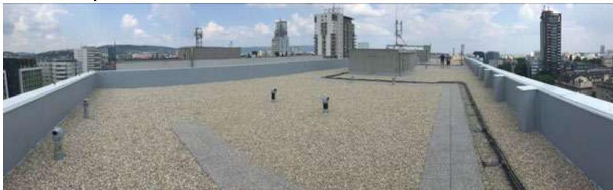
Celkový pohľad na hotovú strechu
