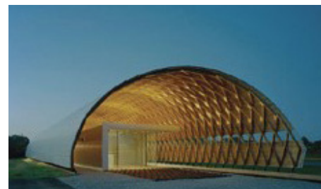
Příklady Zöllingerovy konstrukce z Německa
