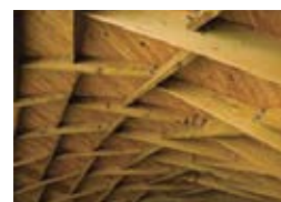
Detail Zöllingerovy konstrukce v Německu
