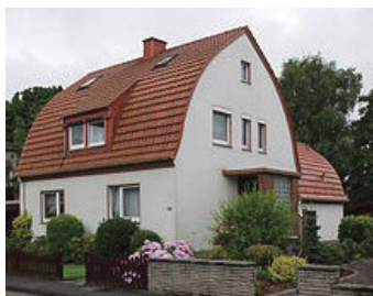
Příklady Zöllingerovy konstrukce z Německa
