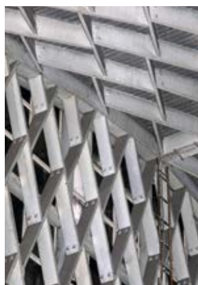
- napojení oblouku a štítu
