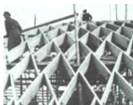
Stavba lamelové konstrukce
